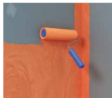
fermacell Flüssigfolie mit der Rolle 2×vollflächig auftragen (Gesamtdicke \geq 0,5 mm), Trocknungszeit: min. 2 Stunden
