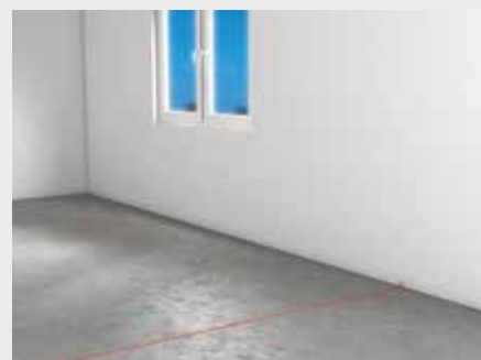
Anlegen der Wandachse mit Schnurschlag oder Hochbaulaser
