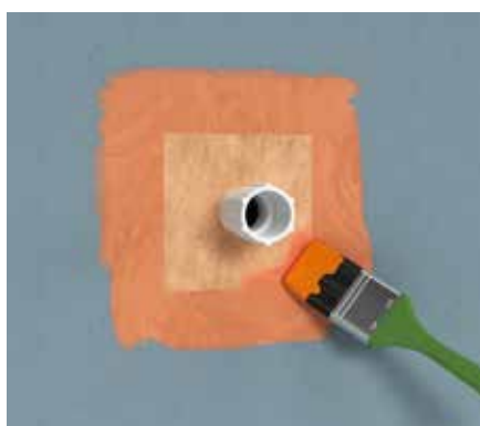
Zur Abdichtung von Rohrdurchführungen die Wanddichtmanschette in die noch feuchte fermacell Flüssigfolie einbetten und direkt erneut überstreichen, Trocknungszeit: mind. 1 Stunde
