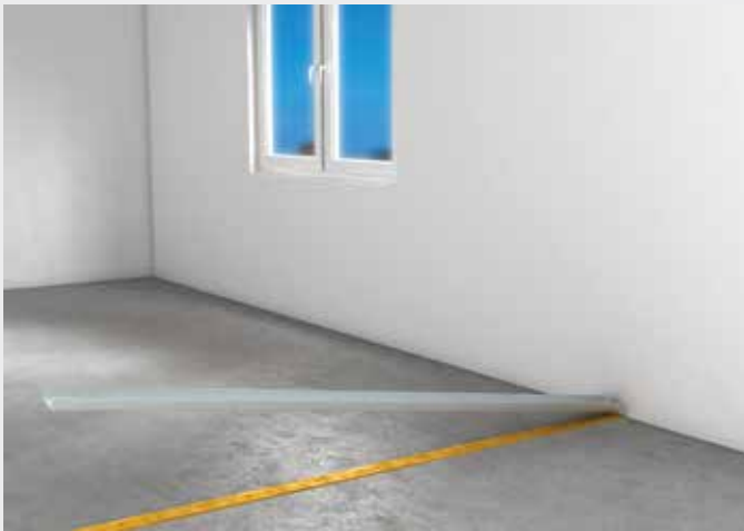
Auslegen der UW-Anschlussprofile am Boden auf Dämmstreifen
