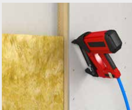
Beplankung der Holzunterkonstruktion mit Klammern
