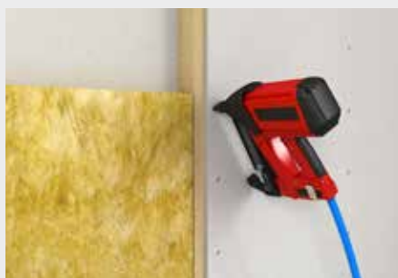
Klammern auf Holzunterkonstruktion
