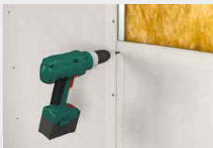
Schrauben auf Stahlunterkonstruktion
