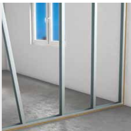
Montage der CW-Ständerprofile
