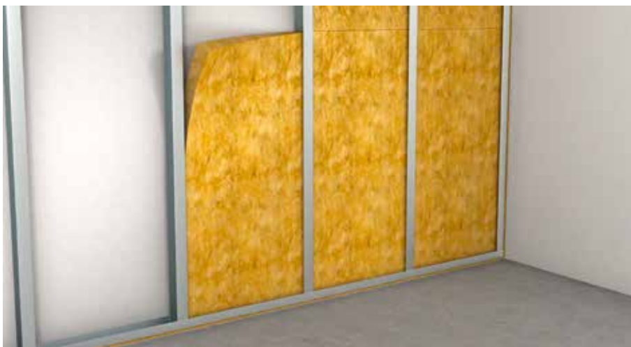
Einbringen der Dämmstoff-Platten
