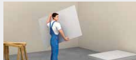
Einzelne fermacell Gipsfaser-Platten hochkant tragen
