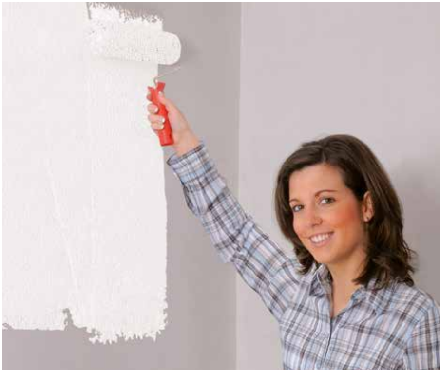
fermacell Rollputz ist mit Dispersions-, Latex-, Acryl- und Silikonharzfarben überstreichbar.
