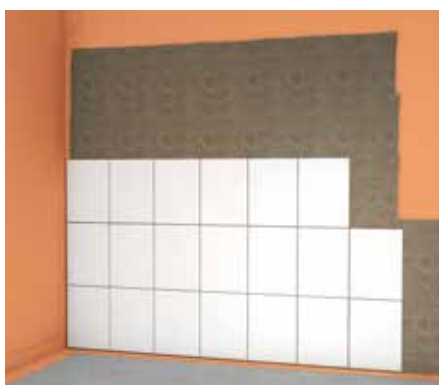
Verfliesung mit fermacell Flexkleber
