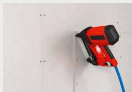
Klammern fermacell Gipsfaser-Platte auf fermacell Gipsfaser-Platte (unterkonstruktionsneutral)
